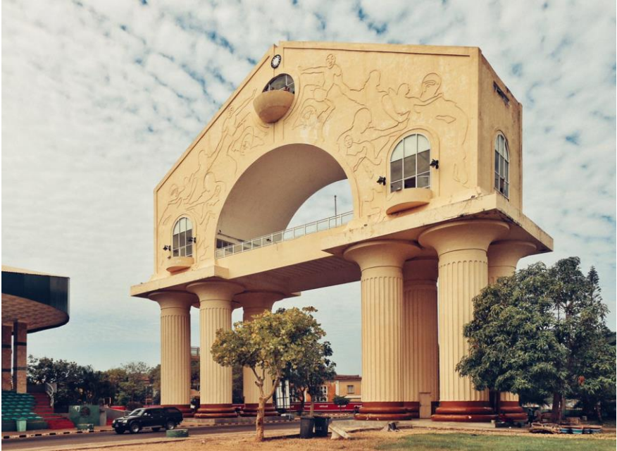
冈比亚地标建筑—班珠尔大拱门
