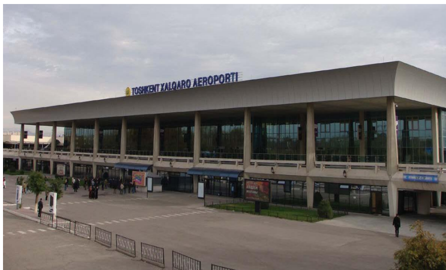
塔什干国际机场
